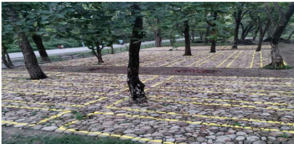
चित्र नं.४- तिलौराकवट साझेदारी वन समुहको घाटगद्दी प्लटमा ढुङ्गा सोलिड (Stone Pitching) र बाटोहरुमा ग्राभेलिड
