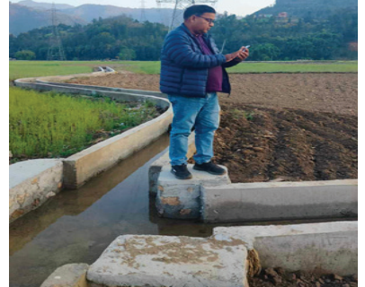
सिचाईकुलो निर्माण (१७५ मि.), तानसेन
