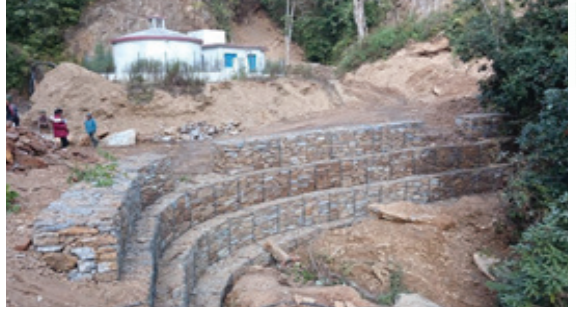
टेवा पर्खाल निर्माण, रिब्दीकोट, पाल्पा
