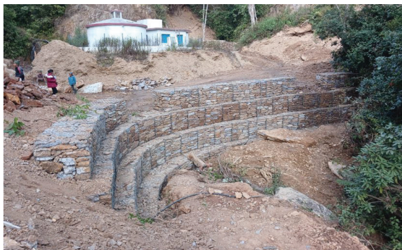
रिब्दिकोट गा.पा. ४ पाल्पामा पानी ट्याङकी तथा सडक पाखोको संरक्षणको लागि टेवा पर्खाल निर्माण
