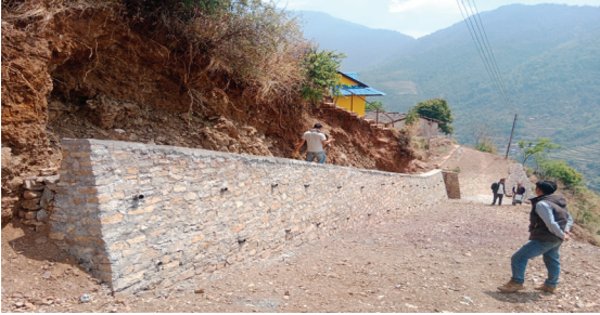
पहिरो रोकथाम: टेवा पर्खाल निर्माण भुमे ३, झुमलवाड, रुकुम पूर्व
